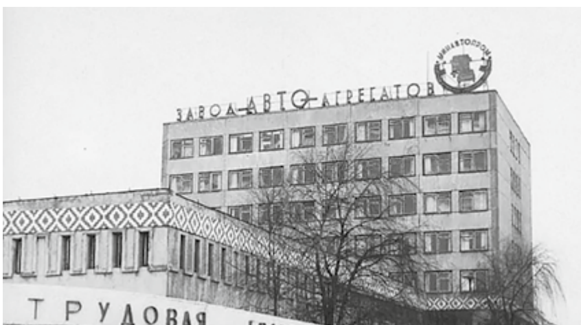
Рис. 9. Высотный корпус завода агрегатов в Гродненском Северном промузле
