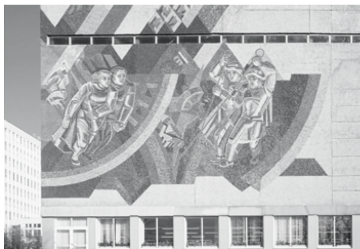
Рис. 12. Мозаичное панно на главном фасаде производственного корпуса завода «Радиоволна»
