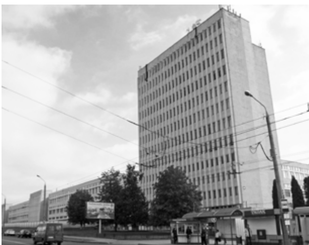
Рис. 11. Высотный корпус радиозавода в Гродненском Северном промузле
