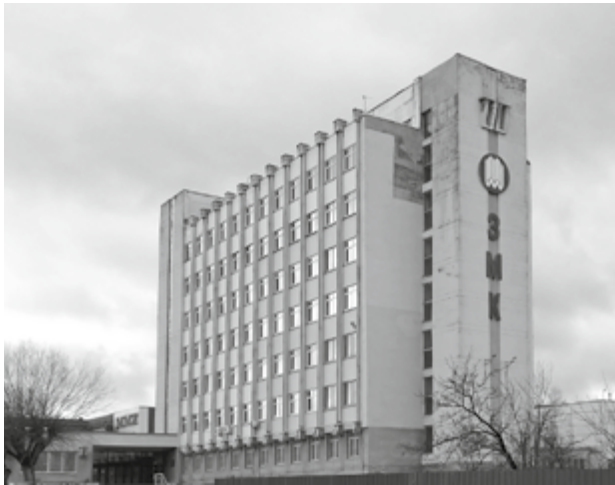
Рис. 6. Высотный корпус заводоуправления на выезде из Молодечно
