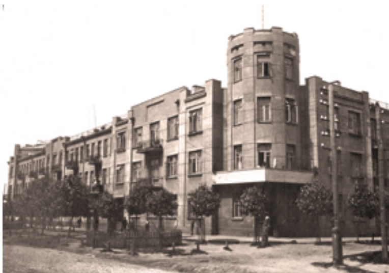
Жилой дом для рабочих и служащих Западной железной дороги. Гомель. 1927 г. Архит. С. Шабуневский. Фото конца 1930-х гг. [1, л. 15]
