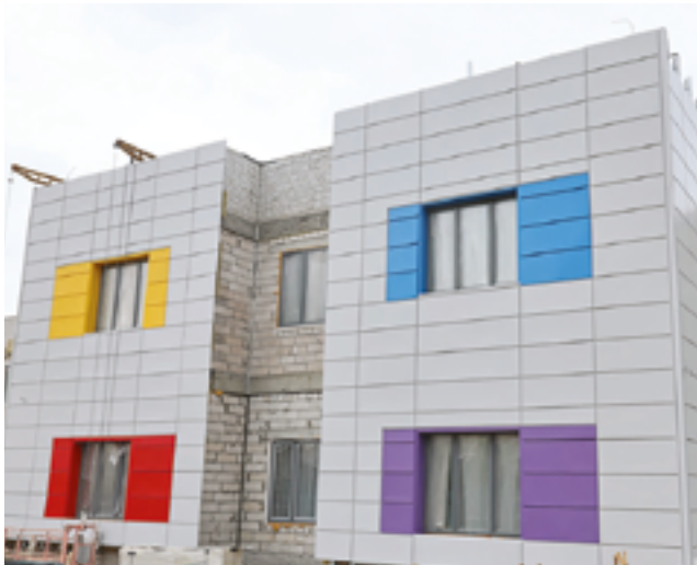
Процесс строительства нового детского реабилитационного корпуса
