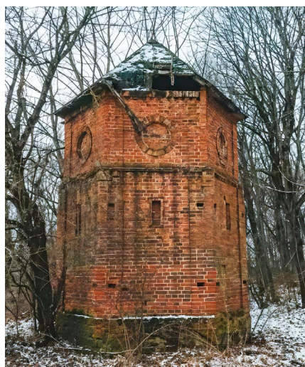
Рисунок 4. Башня-коптильня в усадьбе Рдултовских в Верхнем Чернихово
