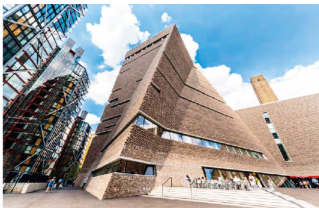
Рис. 7. Пример навесной фасадной системы с кирпичной облицовкой [10]
