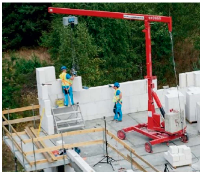
Рис. 3. Монтаж стенового ограждения из крупноформатных силикатных блоков [4]
