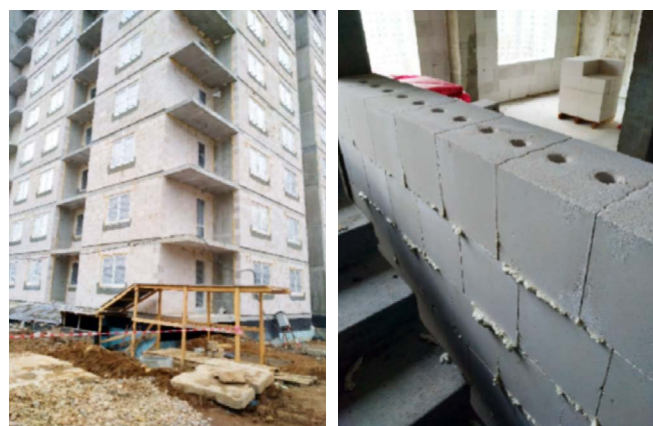
Рис. 6. Строительство жилого дома с монолитным железобетонным каркасом и стеновым заполнением на полиуретановых швах в г. Минске
