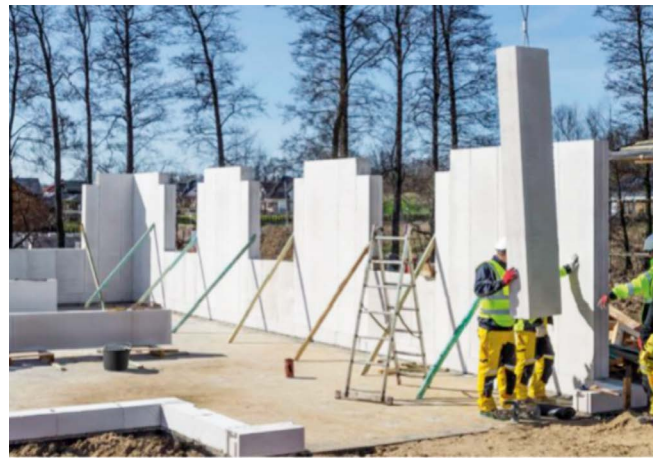
Рис. 5. Монтаж стенового ограждения из крупноформатных элементов из ячеистого бетона [7]
