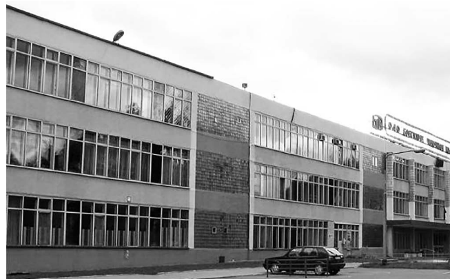
Рис. 3. Фрагмент производственного корпуса чулочной фабрики в Брестском Восточном промышленном узле
