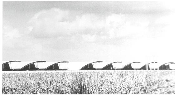
Рис. 14. Пример тотальной унификации – «Томсон оптоэлектроник», Франция, арх. Ренцо Пиано Асс. Все функционально разные пространства собраны всего из двух типов модулей.
