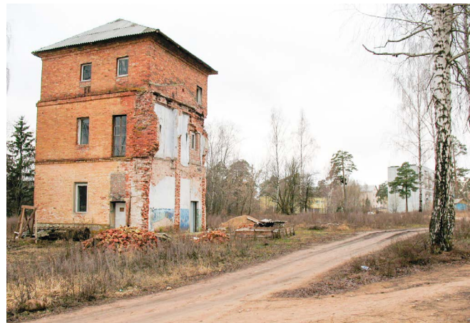
10. Здание бывшей электростанции, в/г Боровка, Краснознаменный Белорусский военный округ. Фото Ю. Глушанина. 03.01.2007
