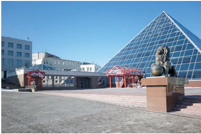
Рис. 15. Торгово-развлекательный центр «Марко-Сити» в Витебске. Фото из открытых источников
